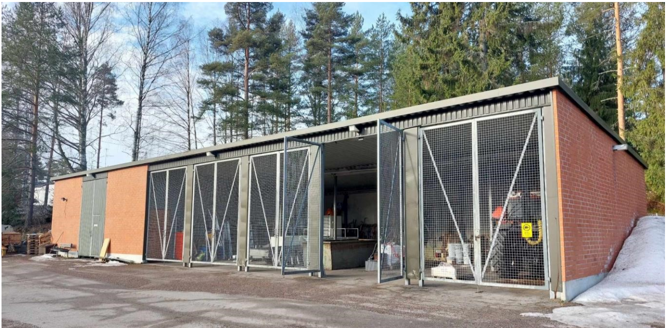
Kuva 8. Teknisen varikon varastorakennus.
