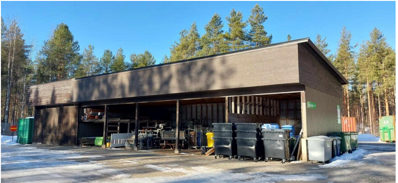
Kuva 21. Kunnan varikko/Jäteasema, Kuortintie 138.
