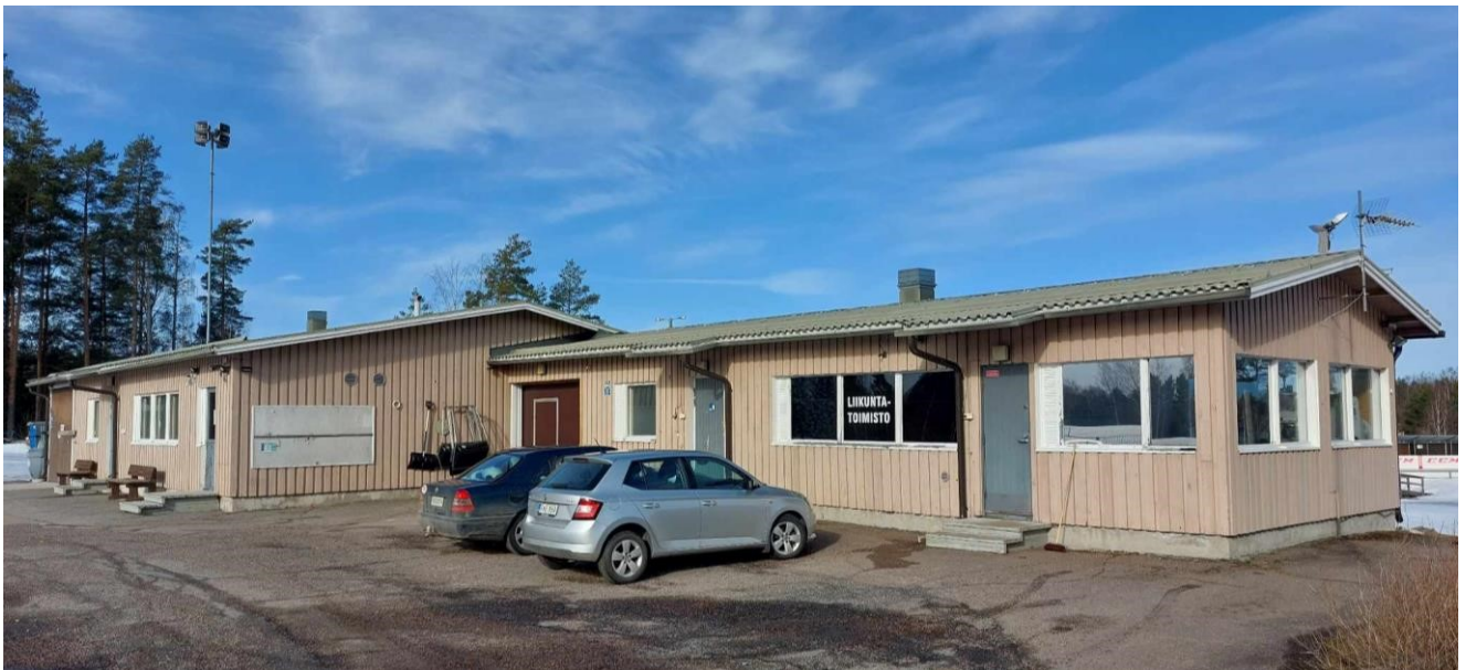
Kuva 67. Huoltorakennus, Mäntyharjun urheilualue. Kuvan rakennuksen kunto heikko.
