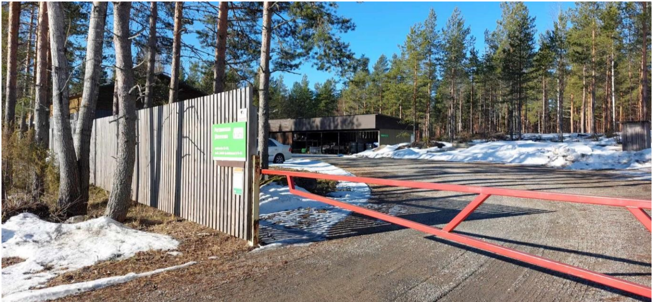
Kuva 19. Kunnan varikko/Jäteasema, Kuortintie 138.
