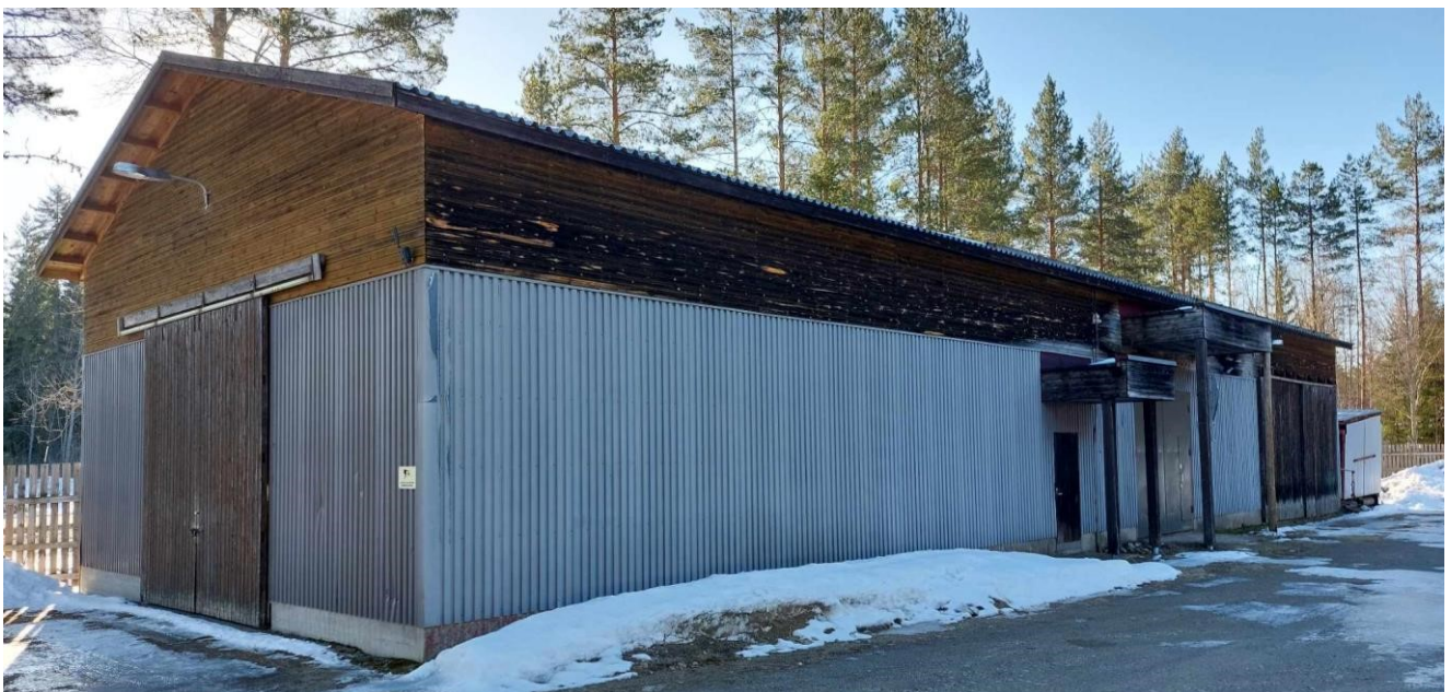
Kuva 20. Kunnan varikko/Jäteasema, Kuortintie 138.
